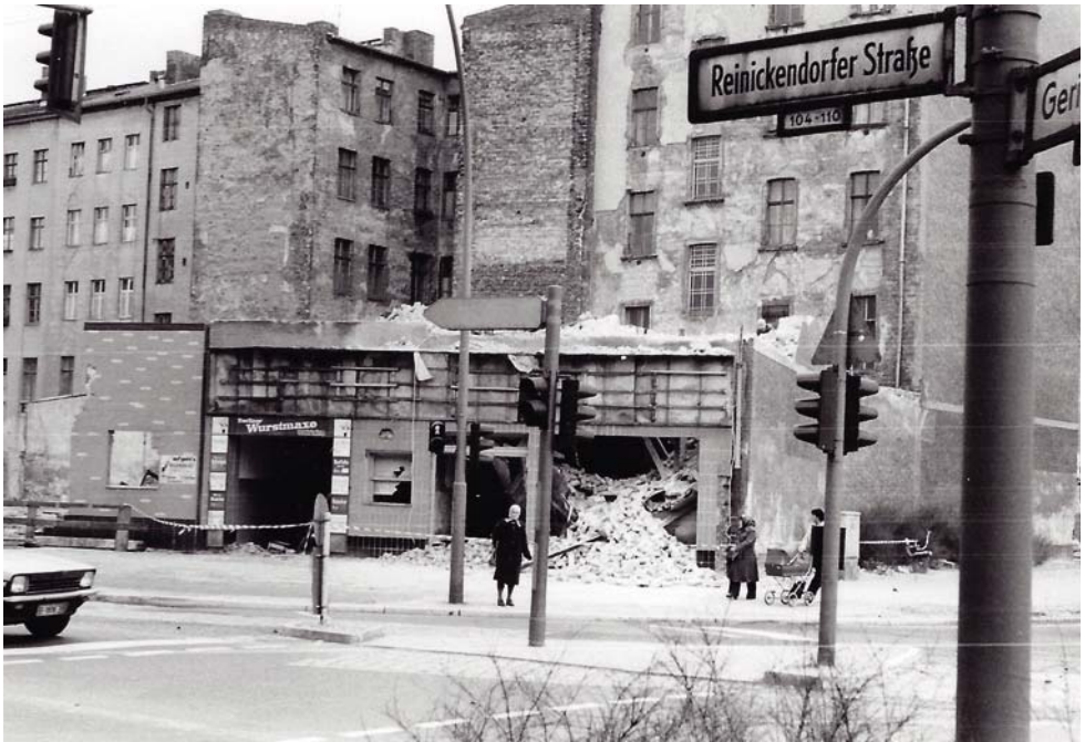
Siebzig Jahre am Nettelbeckplatz: Verfall und Abriss.
